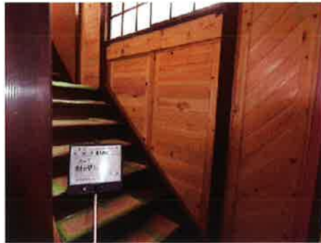
耐力壁の設置
