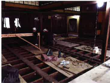
2階床下の補強
