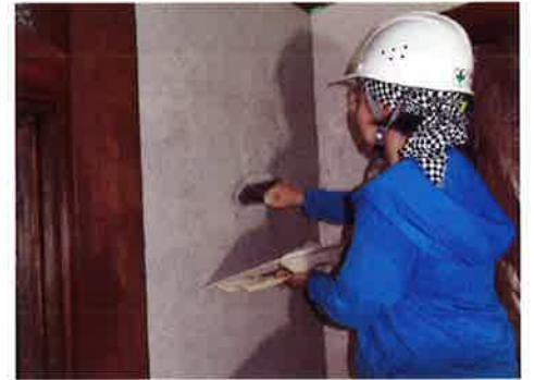
耐力壁の壁塗り
